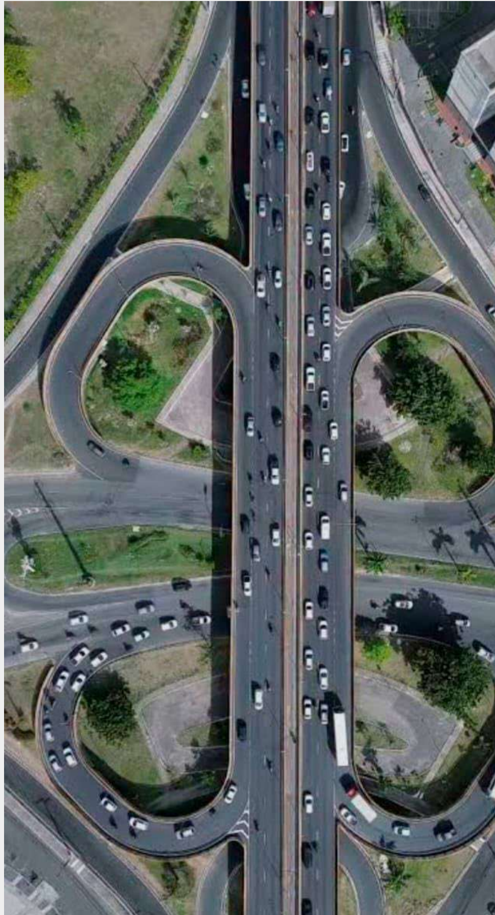
Viaduto do DIA
