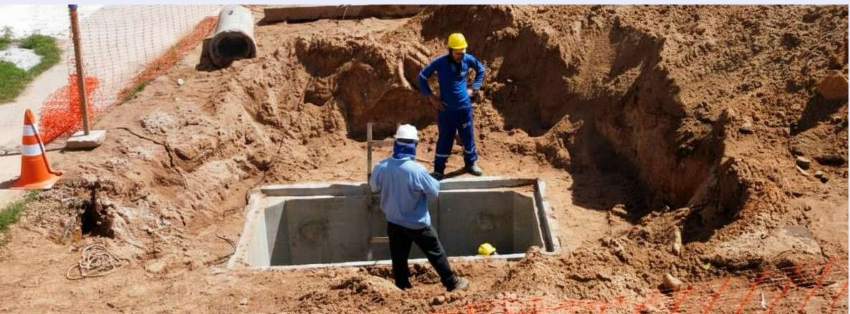
Obra de infraestrutura do bairro Mosqueiro
